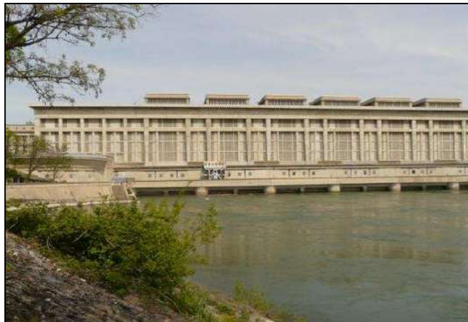
Figure 40 : Usine hydroélectrique Blondel, Bollène
