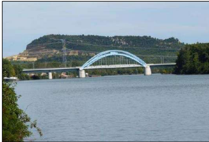
Figure 45 : Pont TGV sur le Rhône au sud Est du site
