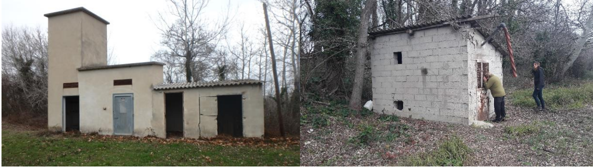
Figure 63 : Transformateur EDF et local agricole des pommiers.
