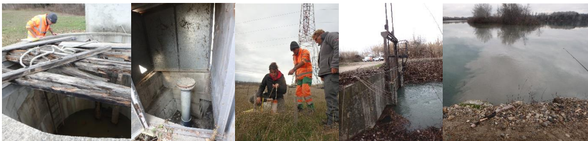
Figure 61 : Aménagements et ouvrages hydrologiques.
