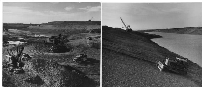
Figure 7 : Travaux d'aménagement du canal de Donzère-Mondragon (©US NARA).
