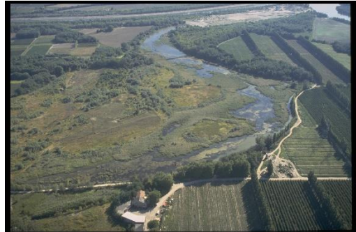
Figure 3 : Vue aérienne de la ferme de Lamiat et de la lône en 1985 (O => E). ©JM FATON
