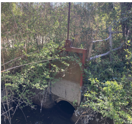
Figure 4 : Martelière vétuste à réparer et canal d'irrigation fortement ensasé à nettoyer sur le secteur du Mas de la Cure
