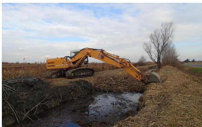
Figure 7 : Curage de canal à Albaron
