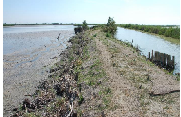
Figure 2 : Digue restaurée sur les marais de Bourgogne, domaine de Rousty, dans le cadre d'un contrat Natura 2000
