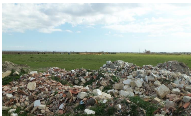
Figure 8 : Travaux de construction à Saliers
