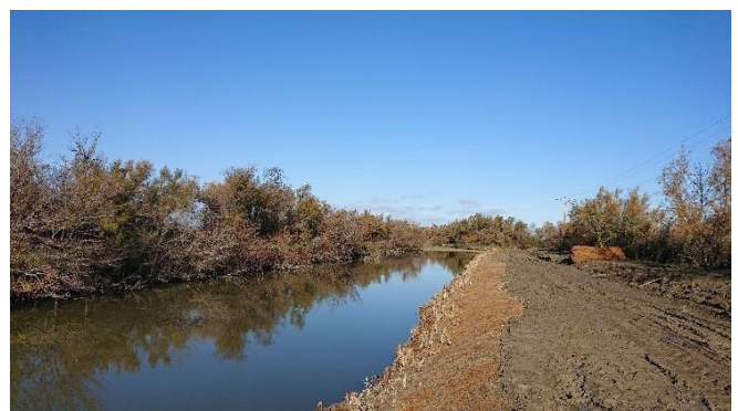
Figure 6 : Travaux canal de Rousty
