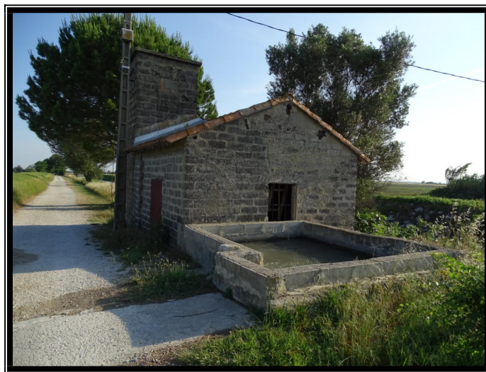
Document 1 : Station de pompage du canal de Rousty (Crédits photo : B. Vollot)
