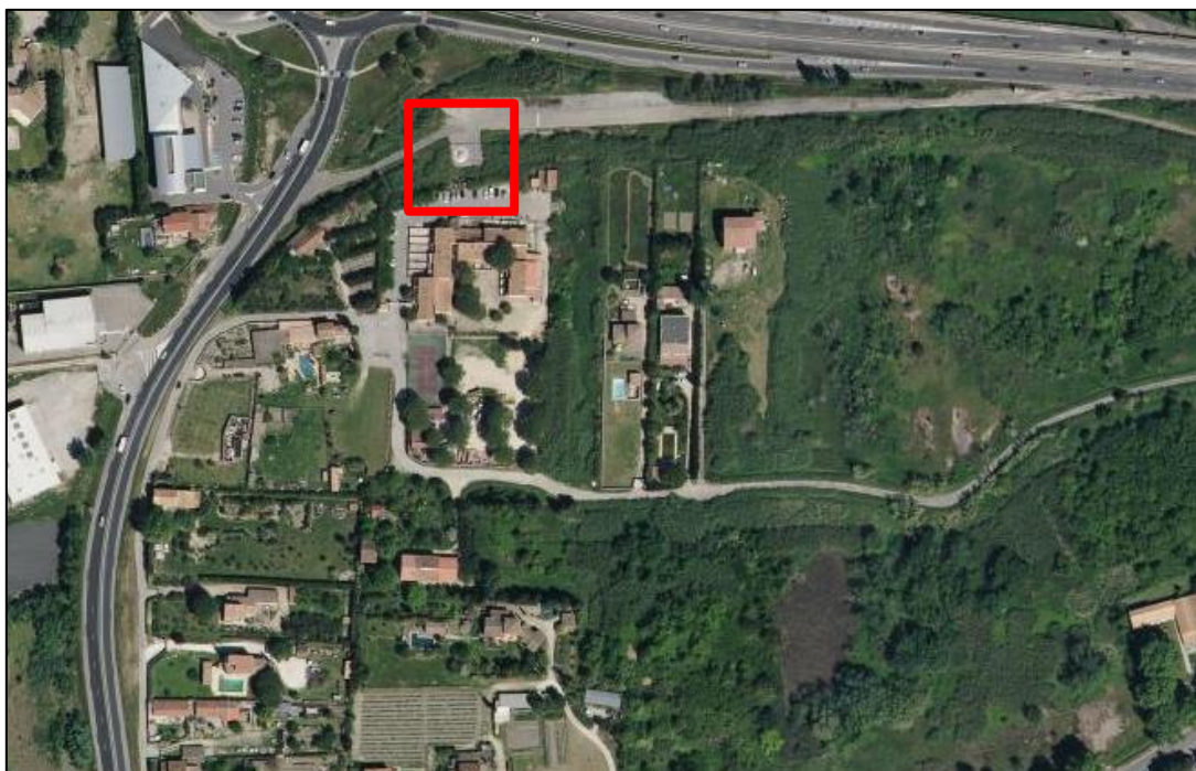
Figure 40 – Localisation du stockage de sel déglacant routier (source Geoportail)
