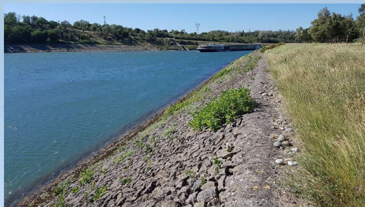
Confortement des berges du canal de fuite de l'usine de Bollène
