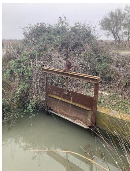
**Figure 2 : Martelière à restaurer et secteur de pose d'une grille anti embâcles sur le Domaine de l'Amarée**
